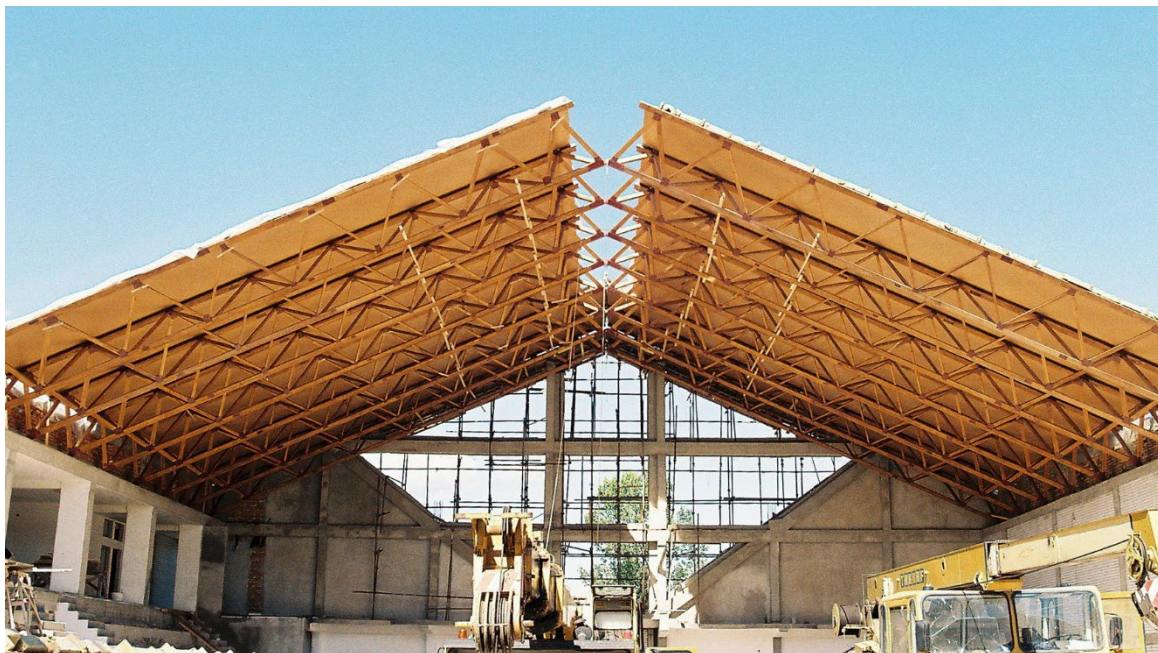
Sl. 2 Premošćavanje velikih raspona LKV nosačima bez potrebe za međuosloncima
