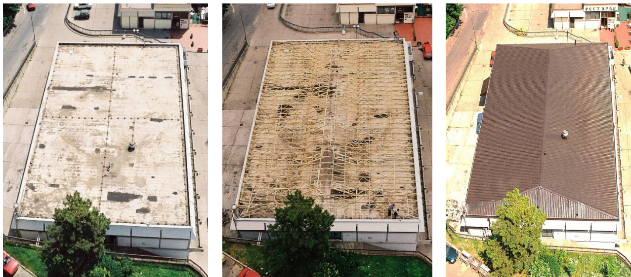
Sl. 3 Sanacija ravnog krova objekta pošte u Rakovici, Beograd
