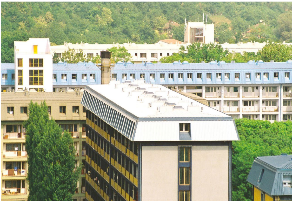
Sl. 4 Rekonstrukcija krovova na objektima Studentskog grada u Beogradu – stvaranje korisnih etaža korišćenjem LKV nosača
