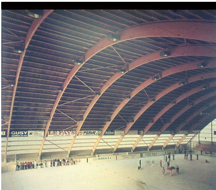
Slika 52. Trozglovni nosač sa pravim štapovima i dvozglovni lučni nosač nad sportskim objektima
