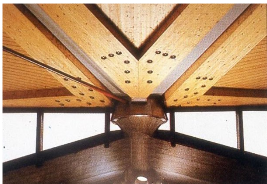
Slika 36. Detalji oslonačkih zglobnih veza
