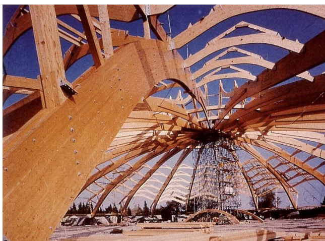
Slika 37. Radijalno orijentisani trozglojni lukovi nad kružnom osnovom
