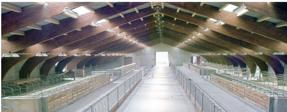
Slika 44. Trozglobni nosači na farmi krava u Bečeju
