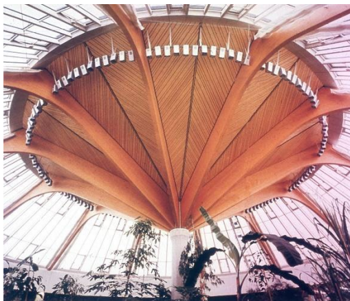
Slika 17. Poligonalna prosta greda u lepljenom lameliranom drvetu
