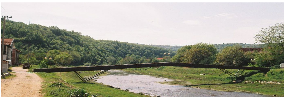
Slika 78. Dve pešačke pasarele u Lebanu
