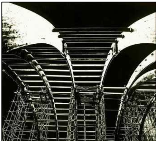
Slika 58. Sportska dvorana u Gostivaru, u montaži LLD konstrukcije
