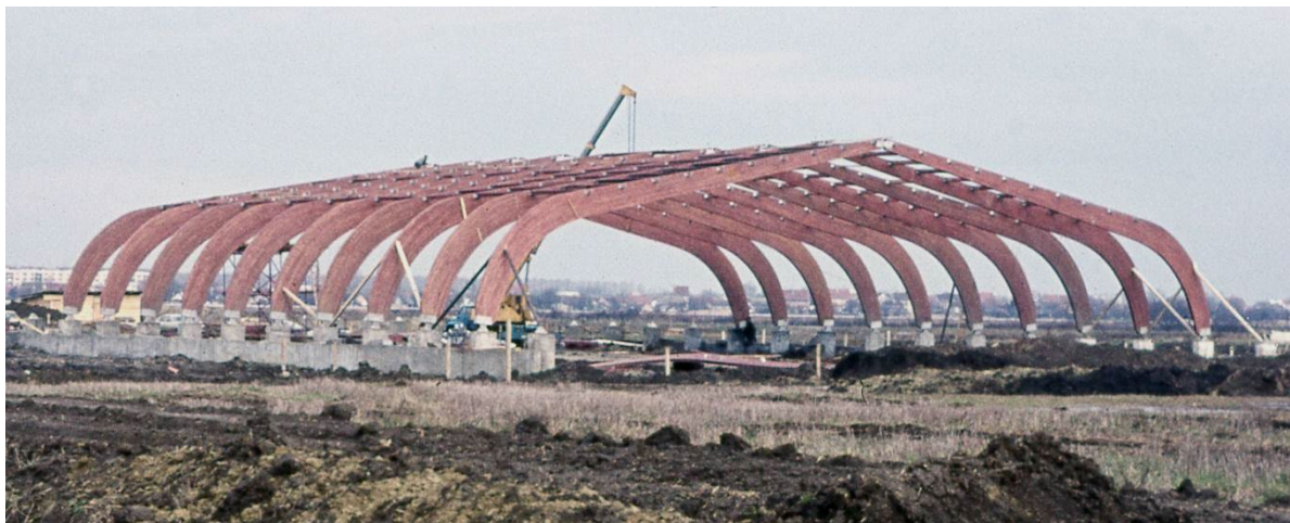
Slika 43. Montaža sistema trozglobnih lukova Panonija - Osijek
