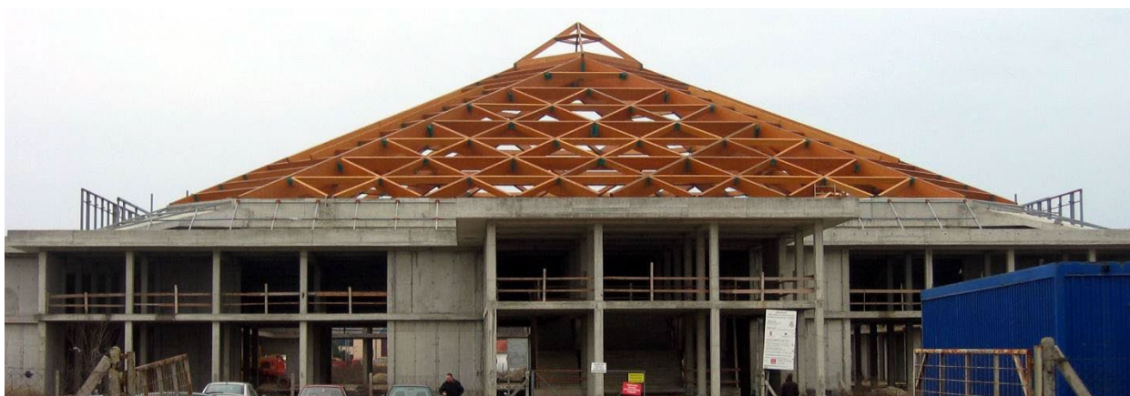
Slika 76. Krovna konstrukcija Sportske dvorane Bagremar, u Pančevu.
