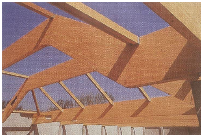
Slika 17. Poligonalna prosta greda u lepljenom lameliranom drvetu
