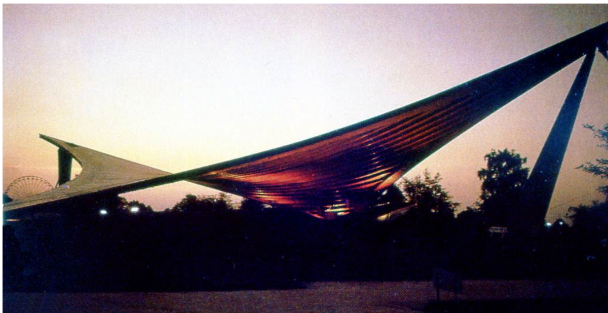
Slika 57. Hiperbolični paraboliod u tehnici lepljenog drveta
