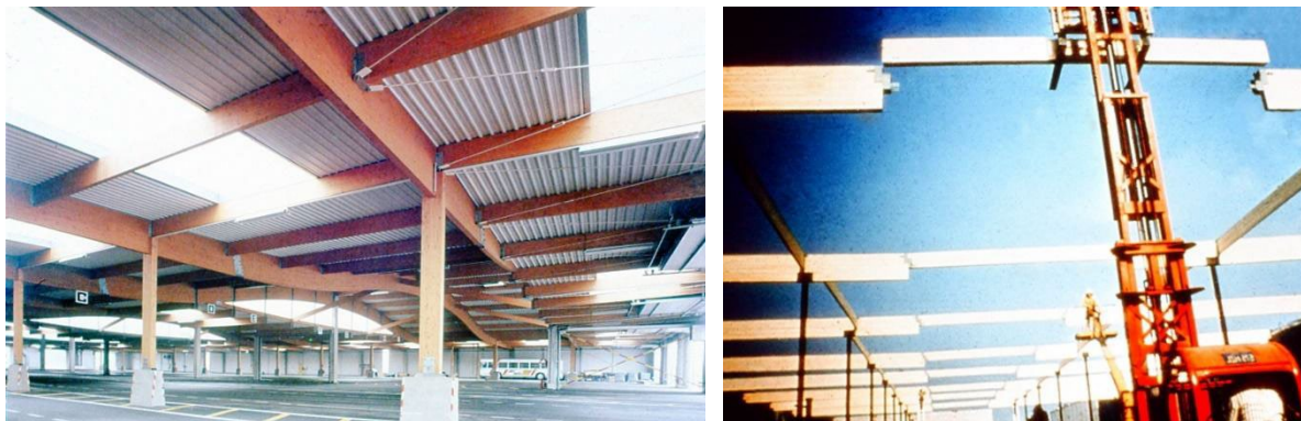
Slika 28. Gerberov nosač
