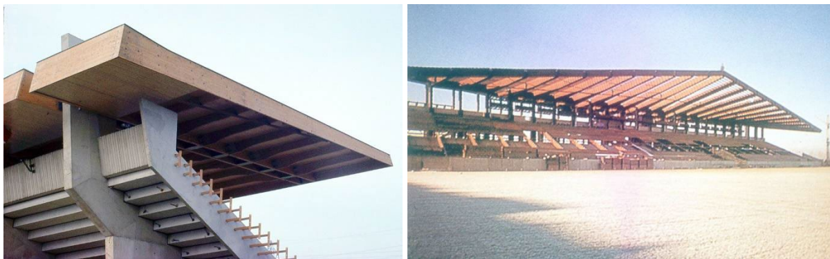
Slika 56. Izuzetno efektni sistemi konzolnih nosača nad gledalištima sportskih objekata
