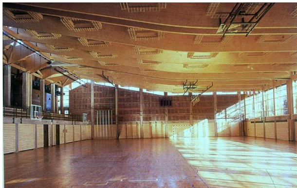
Slika 18. Zakrivljena prosta greda u lepljenom lameliranom drvetu
