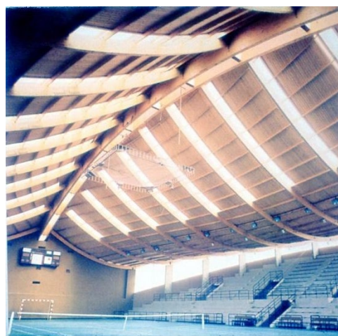
Slika 38. Dvozglojni slemeni luk sa sekundarnim krutim zategama
