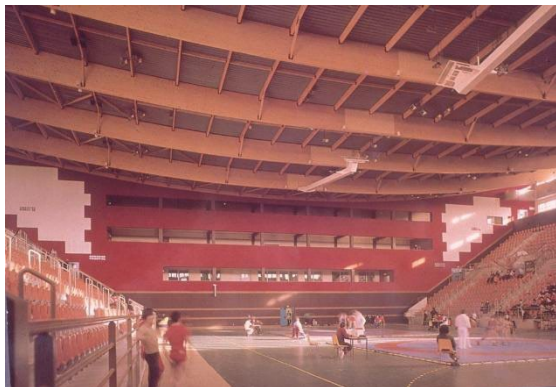
Slika 18. Zakrivljena prosta greda u lepljenom lameliranom drvetu
