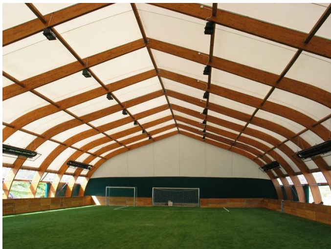
Slika 64. Tipska šatoratsa dvorana za mali futbol
