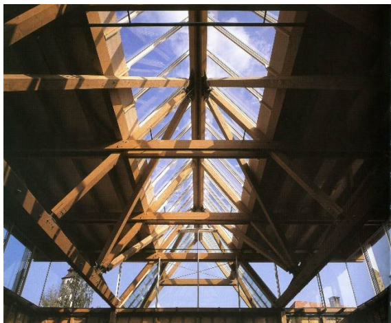
Slika 30. Rešetkasti nosači
