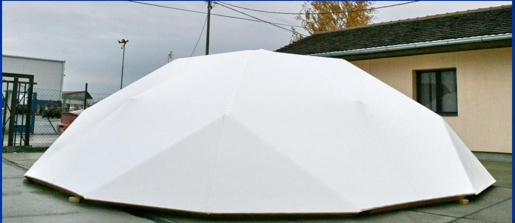
Prototip drvene poliedarske kupole nad kružnom osnovom.
