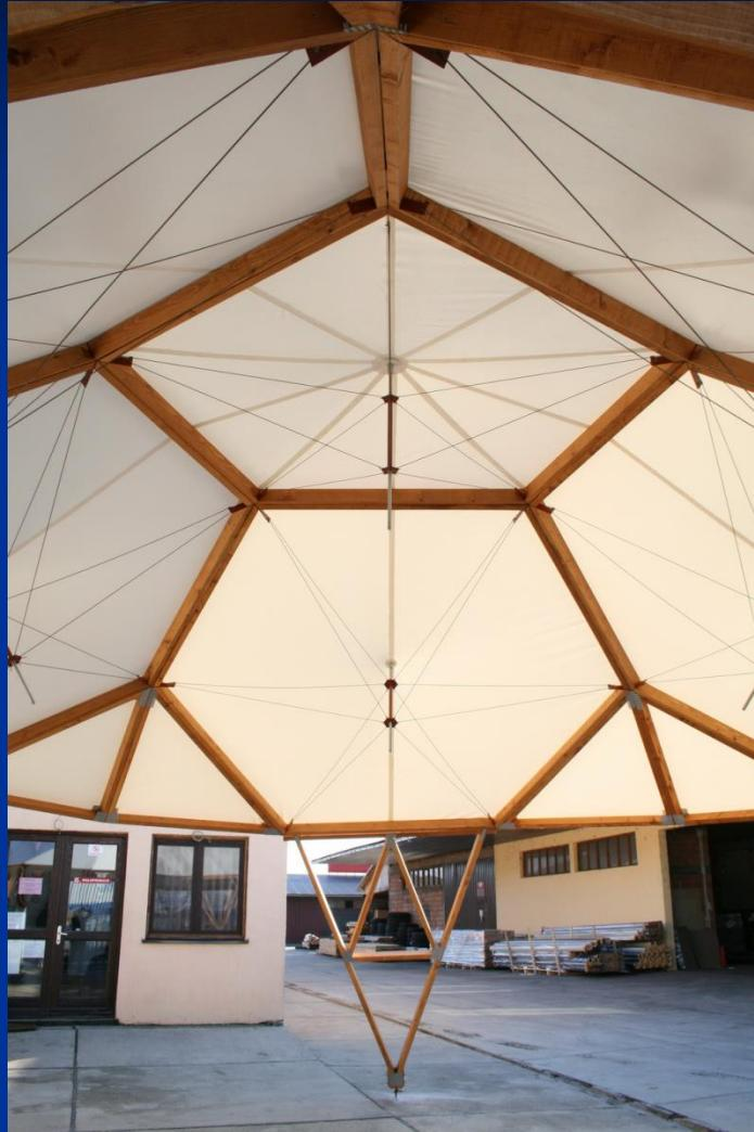
Prototip drvene poliedarske kupole nad kružnom osnovom.
