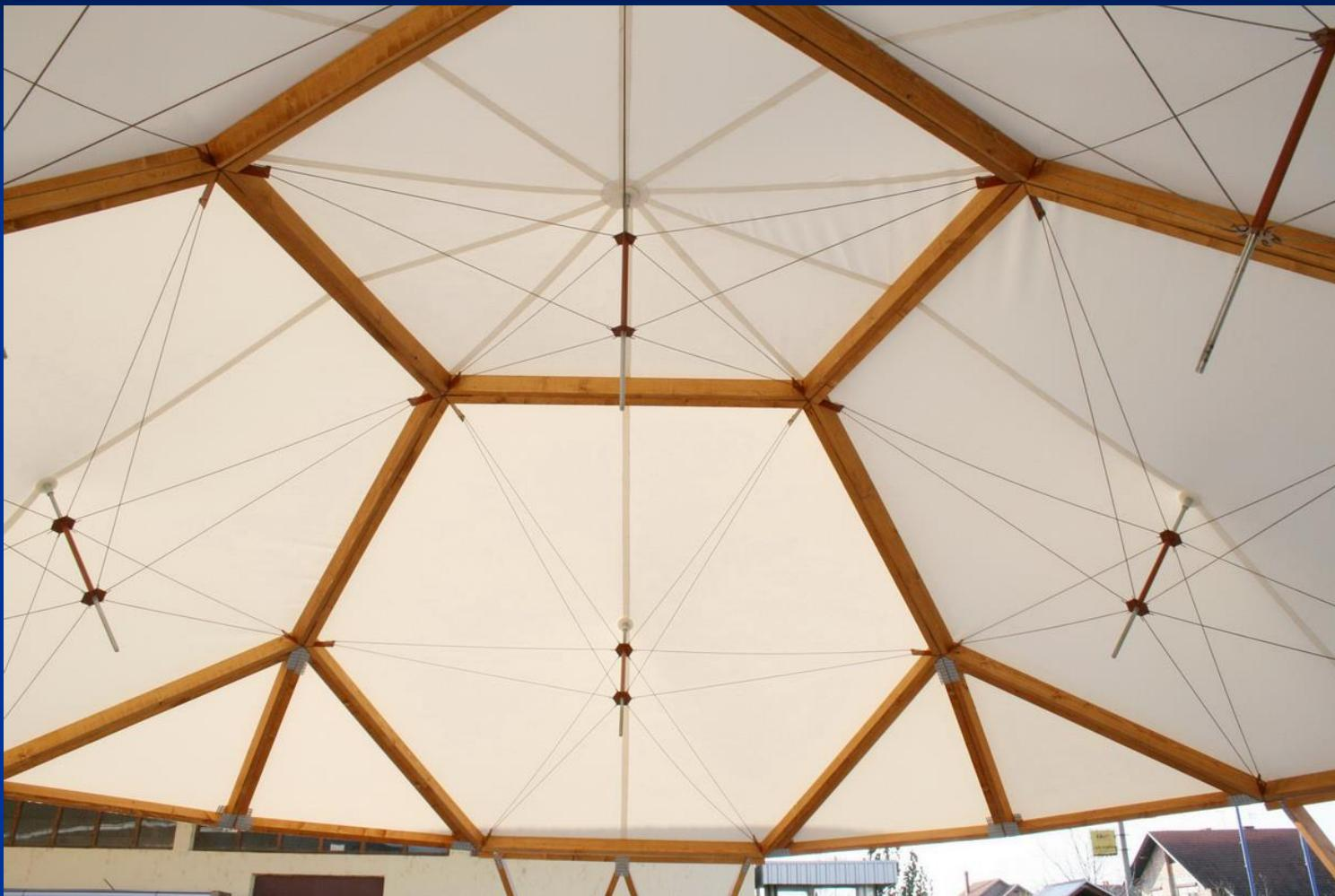
Prototip drvene poliedarske kupole nad kružnom osnovom.
