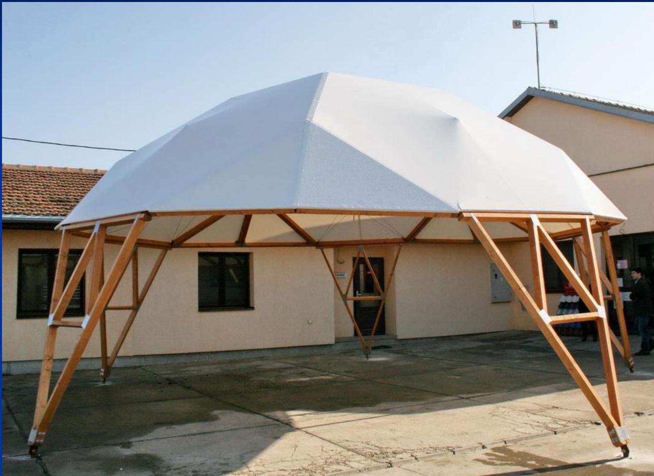
Prototip drvene poliedarske kupole nad kružnom osnovom.
